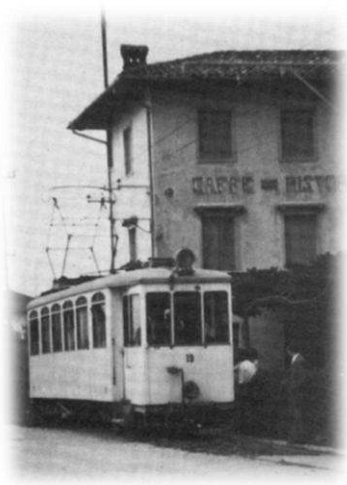
La stazione del tram di Feletto negli anni' 50 ed oggi.
